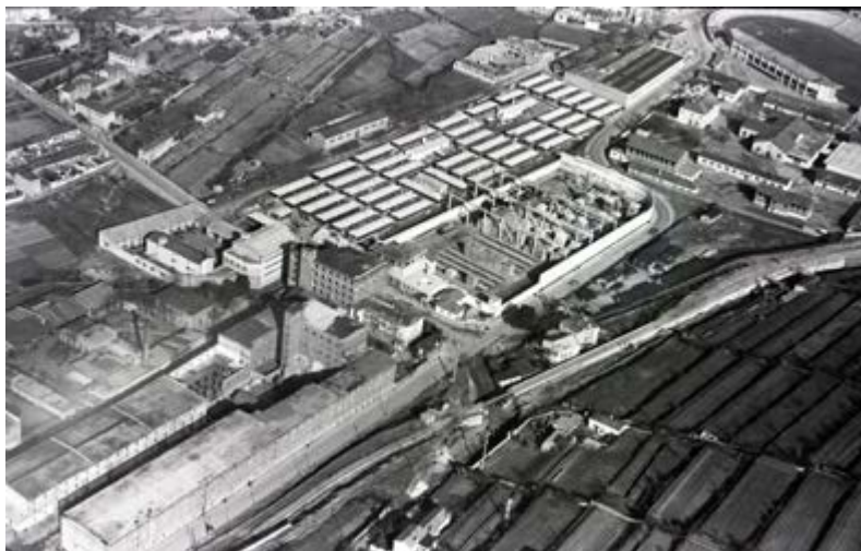
San Sabba, 4 febbraio 1953. Veduta aerea dei due principali campi per profughi stranieri della zona A. Sulla sinistra è visibile il complesso della Risiera, affiancato dallo stabilimento di conserve alimentari "Salvador L. & Co.". Al centro, sopra l'area industriale, spicca l'Annex con le sue file ordinate di baracche, mentre sull'estrema destra si riconoscono il macello civico e lo stadio [Giornalfoto, Fototeca dei Civici Musei di Storia ed Arte, inv. F126550]
